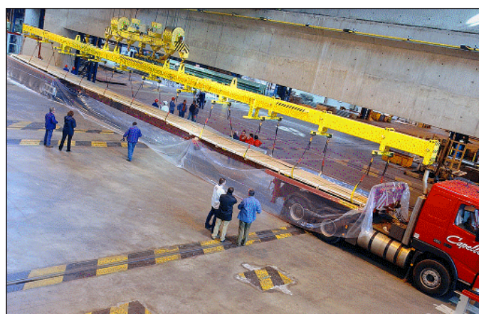
ATOUT. Sur le convoi exceptionnel, deux tôles de 22 millimètres d'épaisseur et pesant 3,5 tonnes chacune, d'une largeur de 2,4 mètres et d'une longueur équivalente à un court de tennis et demi (Photo d'archives : Christian Sagne).
